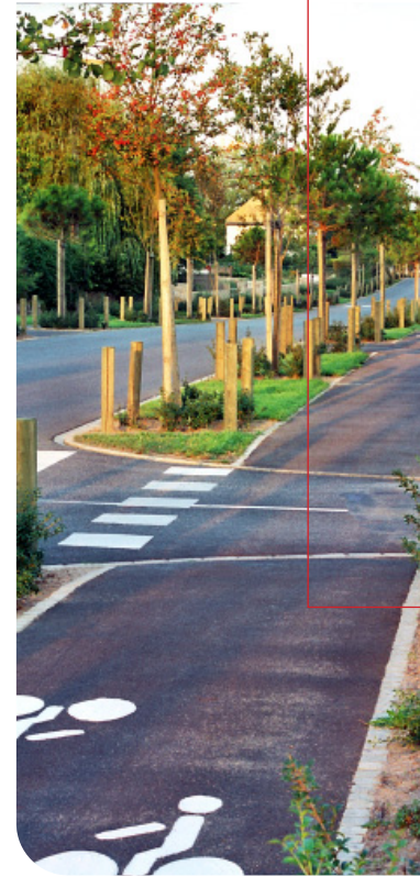
Réduire au maximum les surfaces minérales imperméables et conserver ainsi à cette voie son caractère rural.
