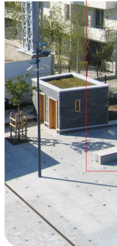
La réalisation des toilettes publiques avec parement des murs en ardoise évoque l'activité locale. La mise en place de toitures végétalisées est un élément important du projet.
