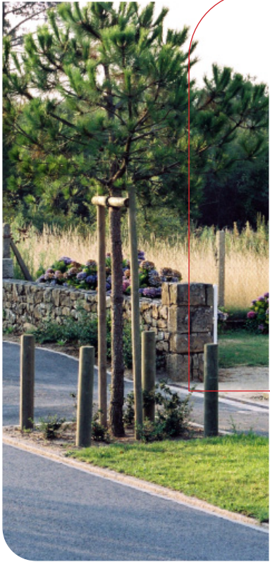
Aménagement - stationnement, piste cyclable, voie de circulation - du chemin départemental 105 à Erdeven.
