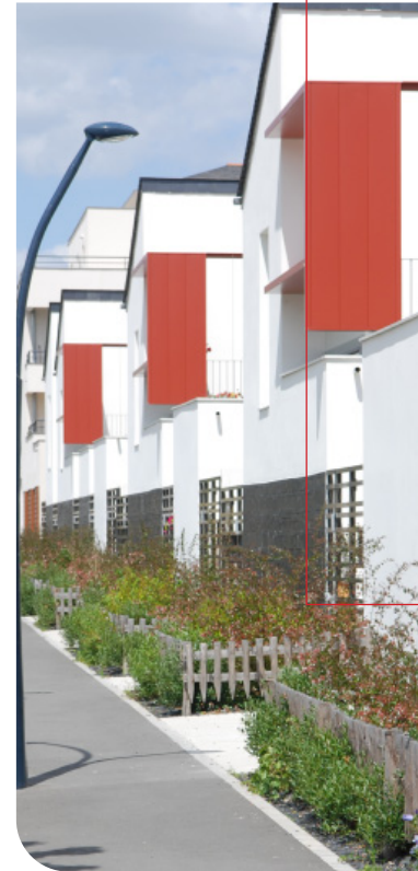
Traitement des pieds des bâtiments en table arbustives persistantes.
