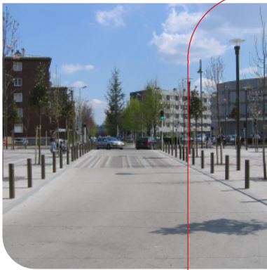
Aménagement du carrefour Leclerc avec le prolongement de la rue Saint Just.
