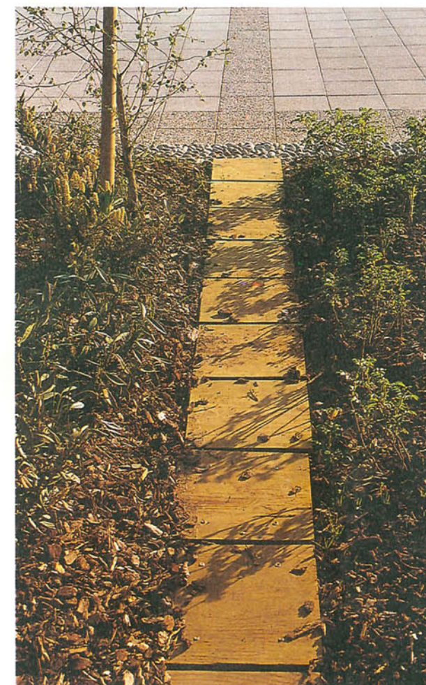
Des sentiers de maintenance réalisés en plaques de bois délimitent des sous-couches dans chaque massif.
